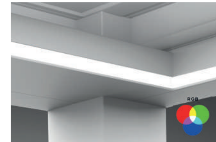
LED-Beleuchtung im Rahmen
